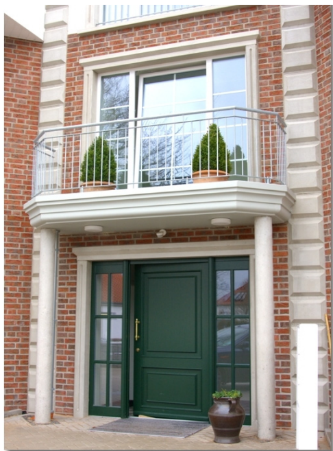
Lisenen, Fensterelemente und Balkonränder aus Beton - stilgerecht eingefügt in ein harmonisches Gesamtbild
