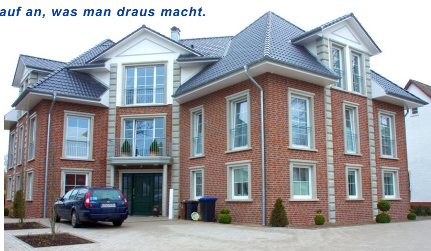
Lisenen, Fensterelemente und Balkonränder aus Beton - stilgerecht eingefügt in ein harmonisches Gesamtbild
