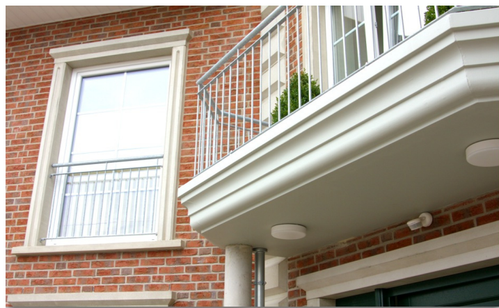
Lisenen, Fensterelemente und Balkonränder aus Beton - stilgerecht eingefügt in ein harmonisches Gesamtbild
