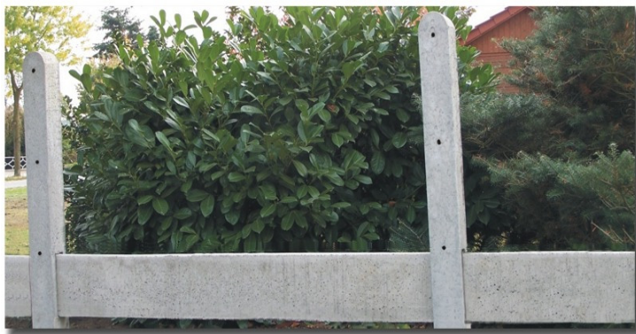
Einfriedung mit 25er Stellkanten und Betonpfählen für zusätzliche Zaundrahtbefestigung
