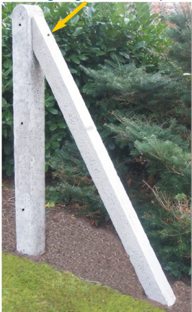
Betonpfahl mit Strebe
