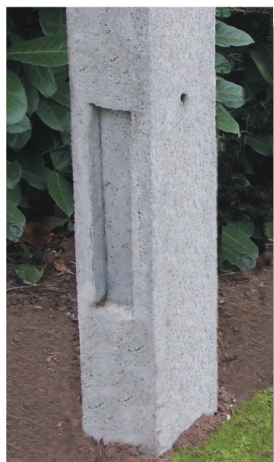
Zaunpfahl mit Ausnehmung ( ca. 2,5 cm Auskerbung )
