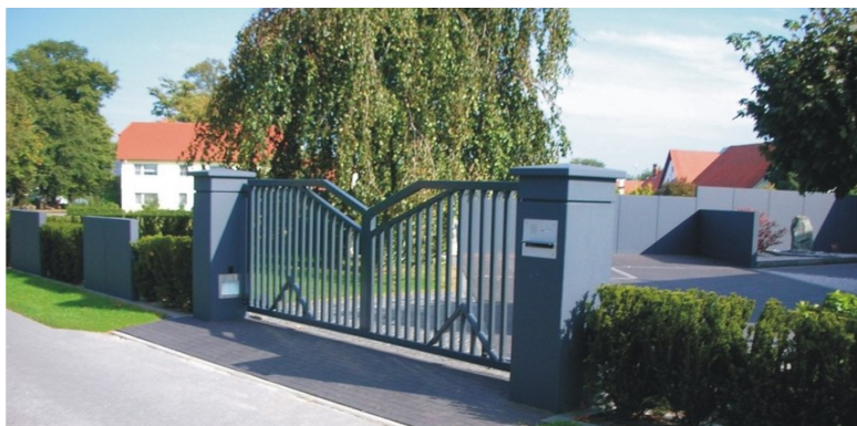
Torpfeiler aus Sichtbeton
