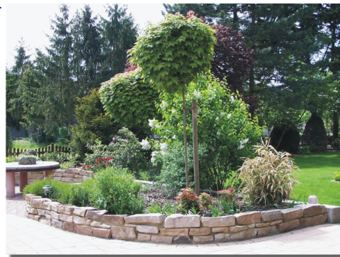
Hochbeet mit Trockenmauer aus "Ibbenbürener Sandstein" mit Schnittkante - in Mörtel gesetzt -
