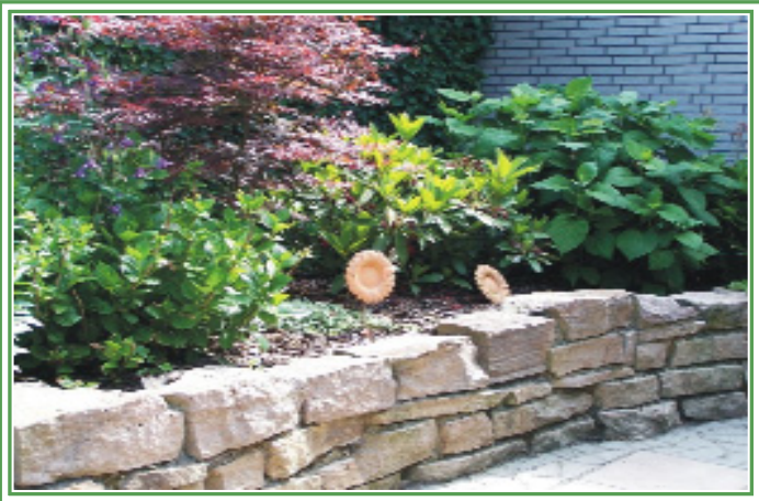
Trockenmauer (gesägte Flächen) aus "Ibbenbürener Sandstein" in Lehm gesetzt
