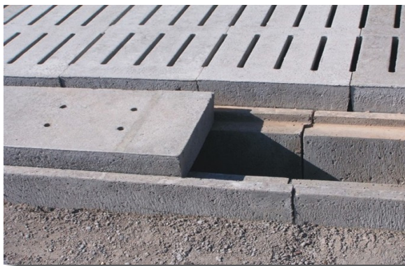
Entwässerungskanal für Oberflächenwasser (mit Nut + Feder)
